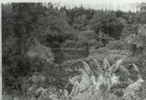
土石があふれ出る寸前の弥生跡地「調整池」
